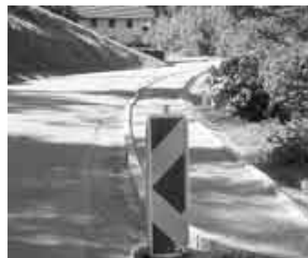
Pločnik in cestišče na Hotavljah bodo prihodnji mesec še asfaltirali.
