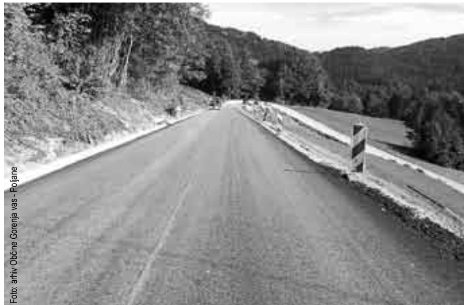
Sanacijska dela na cesti v Javorje naj bi bila dokončana še v tem mesecu.
