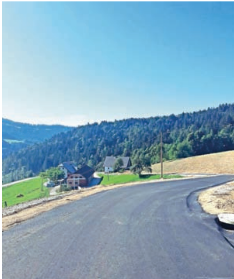
Obnovljen odsek ceste nad kmetijo Burnik
