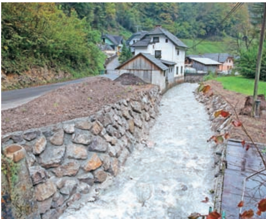
V Poljanah nadaljujejo urejanje vodotoka Hotoveljščica. FOTO: GORAZD KAVČIČ
