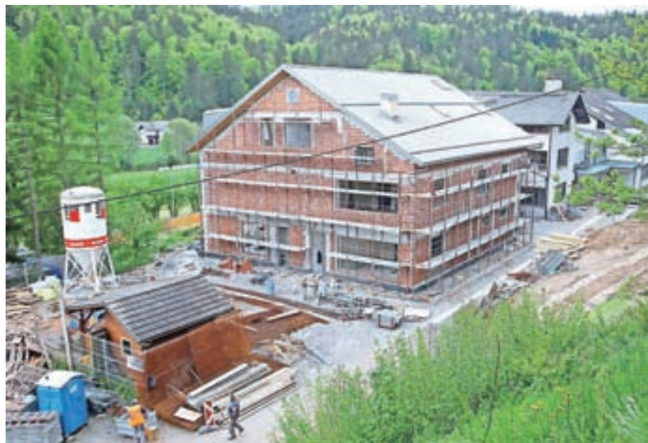
Dela na prizidku Vrtca Agata Poljane potekajo po načrtih. FOTO: GORAZD KAVČIČ
