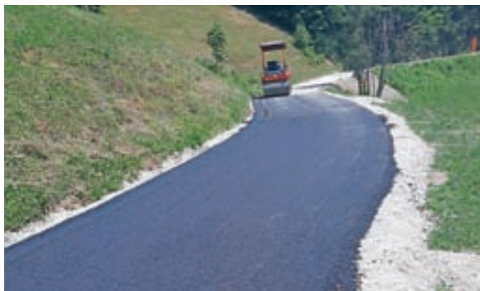
Obnovljena cesta Grapa–Podčrtar–Stata FOTO: ARHIV KS SOVODENJ
