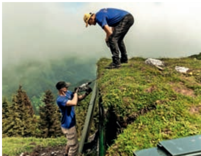
Pomoč pri obnovi radioamaterske postojanke na Blegošu.
