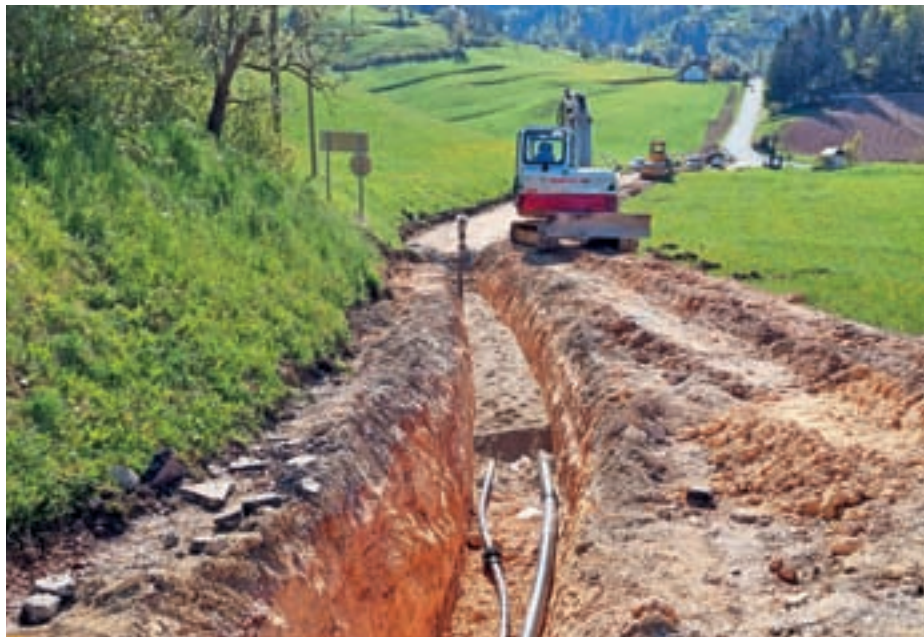
Gradnja vodovoda v Prelesju FOTO: BERNARD STREL
