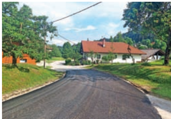
Nov asfalt na cesti v Suhem Dolu FOTO: ARHIV OBČINE
