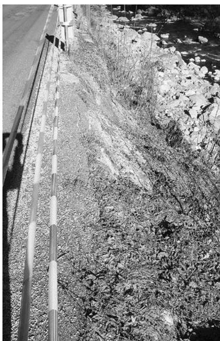
Komaj se zapelješ okrog ovinka, je ponovno udrta bankina, brez betonskih stebričev.
