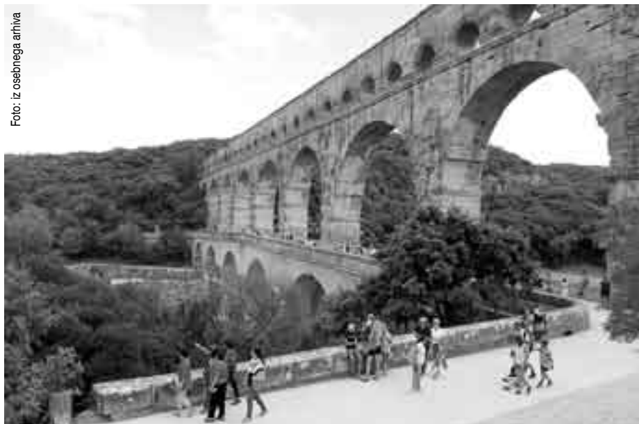
Akvadukt Pont du Gard – Vodni kanal dolžine 50 km je imel povprečni padec 25 cm/km. Kakšni izjemni gradbeniki so bili Rimljani!
