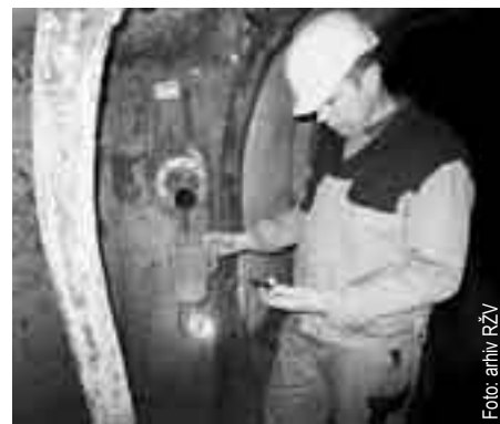
Merjenje pretoka na eni od narejenih vrtin pod Borštem
