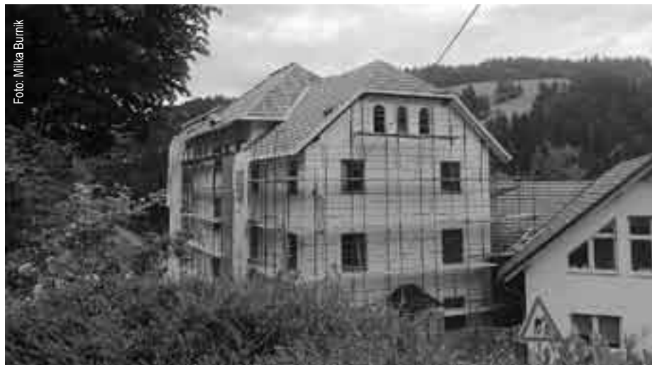
Eden zadnjih objektov, ki je energetska saniran, je stavba podružnične šole na Sovodnju.
