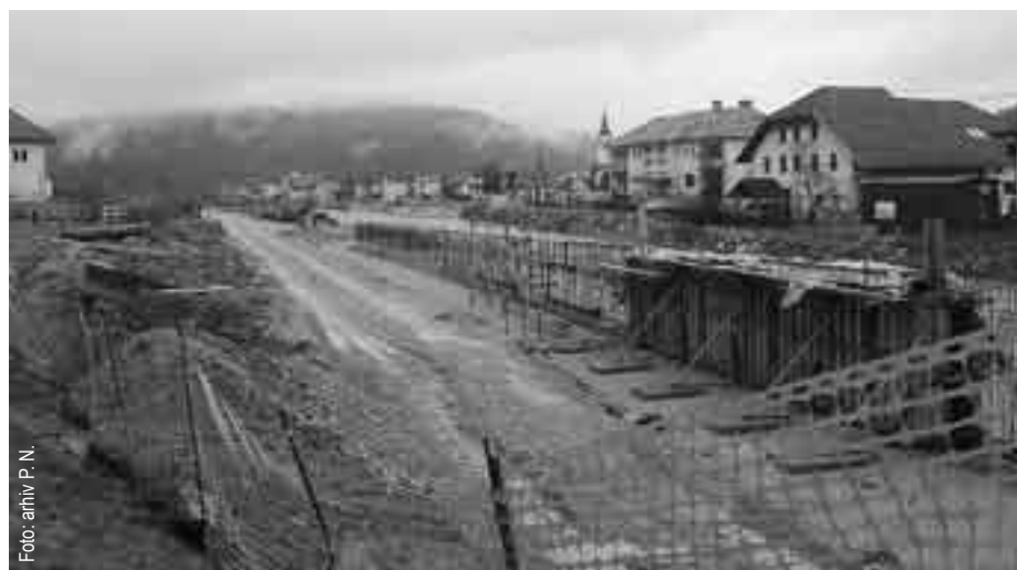
Februarja 2014 ob izgradnji obvoznice v Gorenji vasi. Ob odprtju 2015 je središče vasi močno razbremenila tranzitnega prometa.
