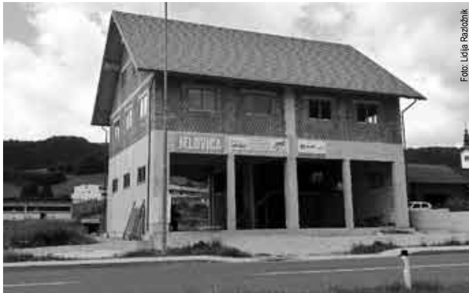
Gasilski dom v Gorenji vasi bo zgrajen predvidoma prihodnje leto.
