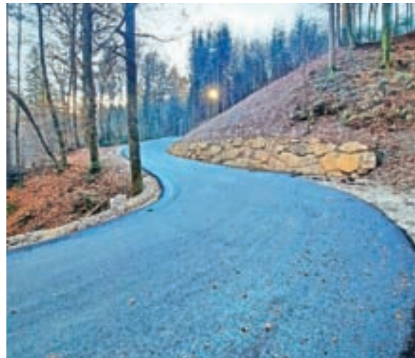
Obsežno razdejanje po poplavah leta 2014 je v dolini Hotoveljščice zahtevalo večletno postopno sanacijo. FOTO: ANTON DEBELJAK
