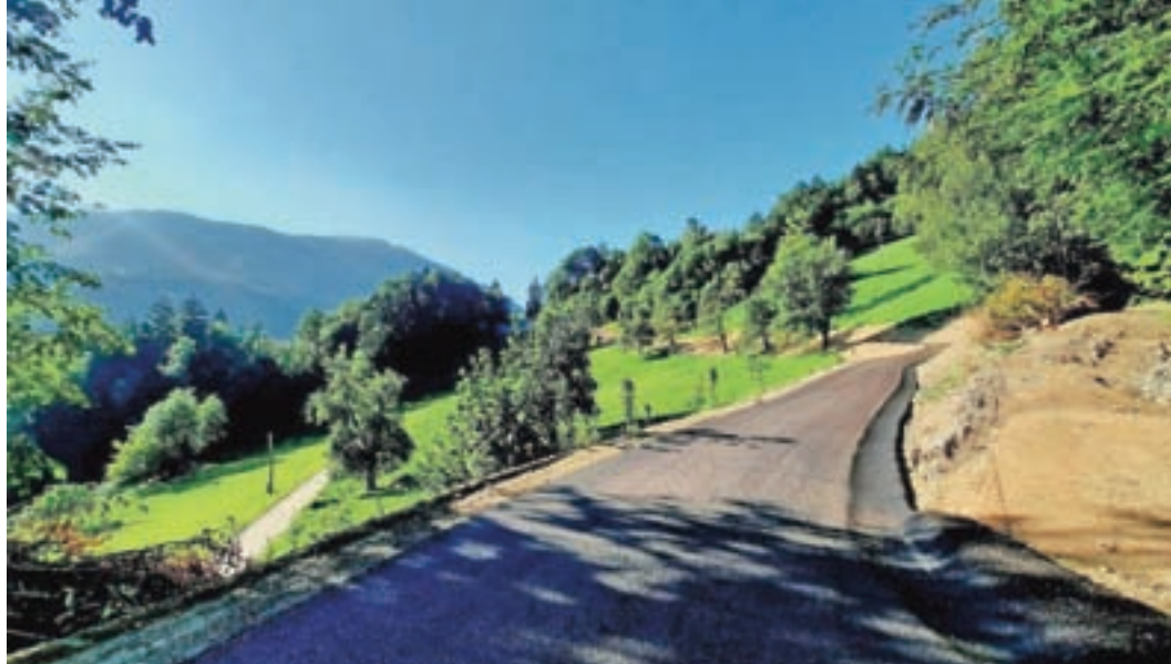
Asfaltiranje ceste Malenski Vrh–Ajnžuc
