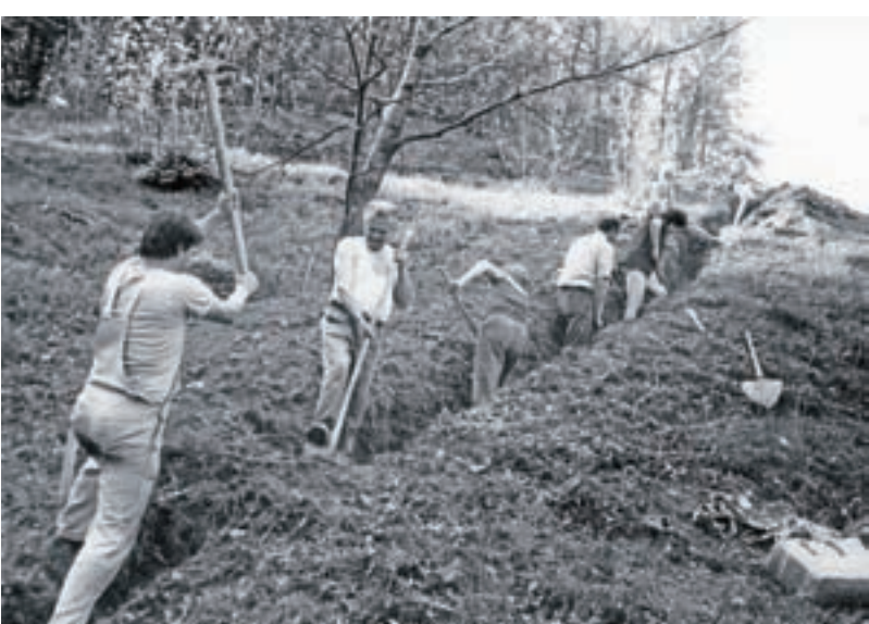
Gradnja telefonije in vodovoda v letu 1985 ...
