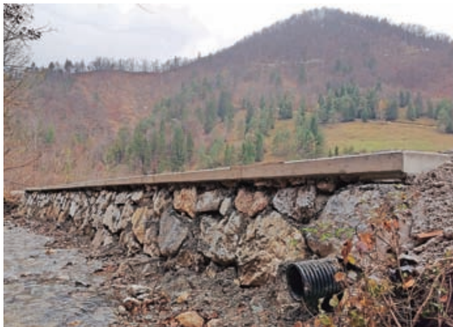
Podporni zid v Kopačnici bo preprečil vodno erozijo na območju ceste.
