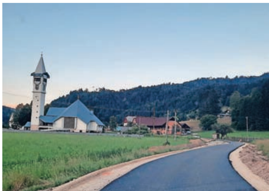
Junija je bila asfaltirana cesta v Predmostu – odcep Podbregar v dolžini tristo metrov. FOTO: ANTON DEBELJAK
