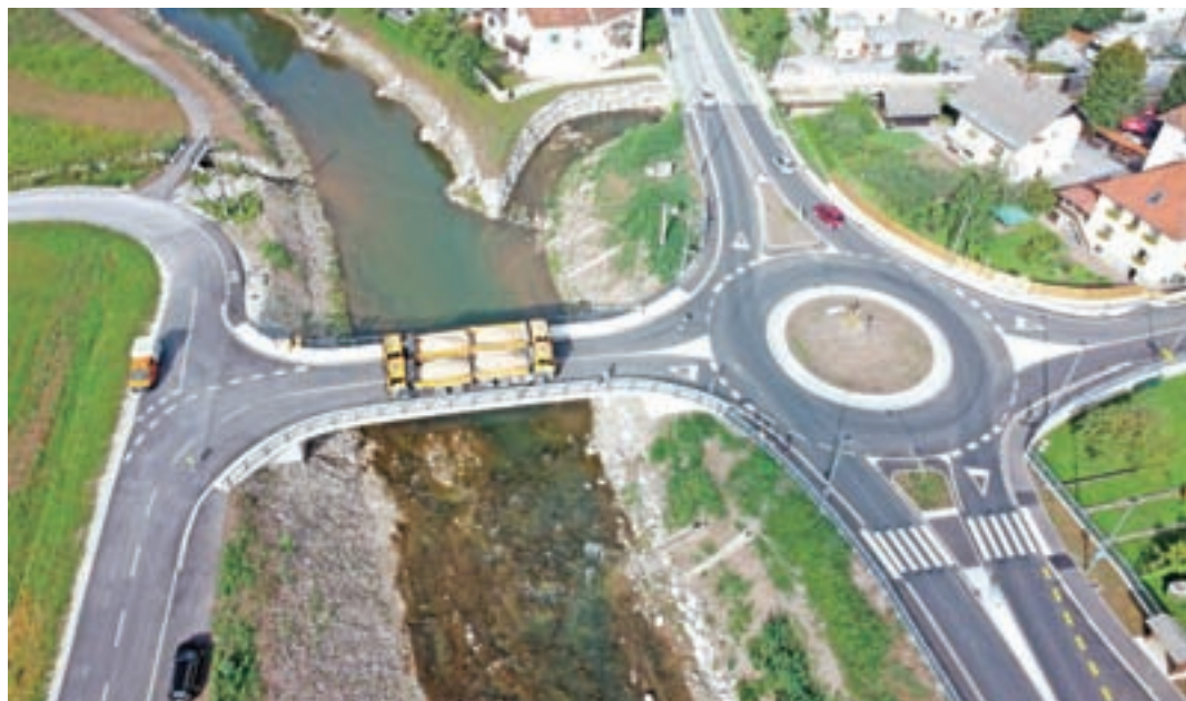
Urejen izliv Ločivnice v Soro, novo krožišče in most v Poljanah. Fotografija je bila posneta ob težnostnem preizkusu mostu. FOTO: ARHIV GGD
