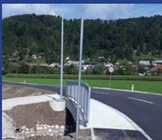
Obnova ceste Gorenja vas - Todraž
