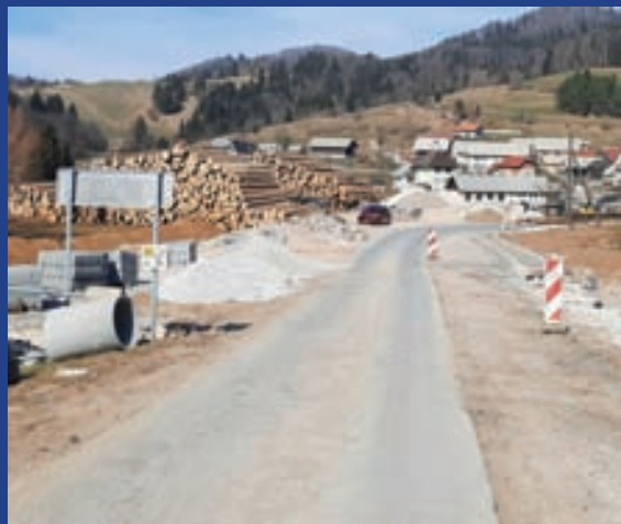
Obnova ceste Lučine - Suhi Dol
