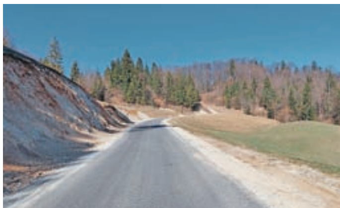
Obnovljeni odsek ceste nad Kovkarjem
