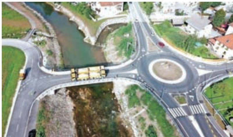
Zaključil se je projekt protipoplavne ureditve Poljan, v okviru katerega je bilo zgrajeno tudi novo krožišče.
