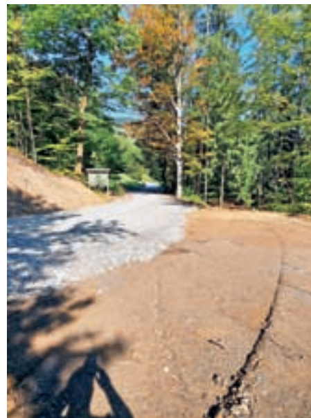
V začetku avgusta se je v Zaprevalu začela sanacija 600 metrov dolgega odseka ceste. FOTO: ARHIV OBČINE
