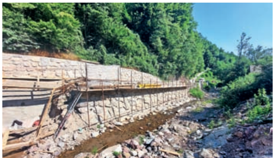
Gradnja podpornega zidu ob mostu na Fužinah FOTO: ARHIV OBČINE
