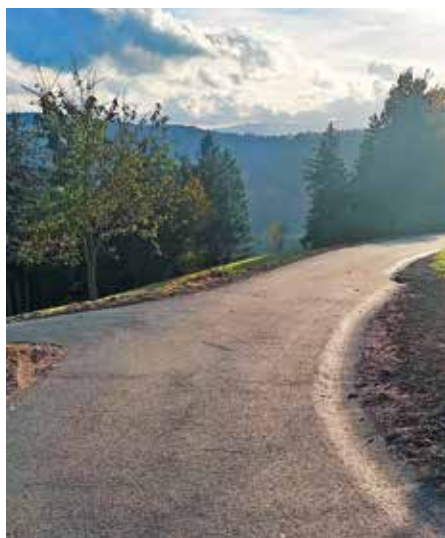
Asfaltirana cesta proti Vrhovcu FOTO: DOMEN PLATIŠA
