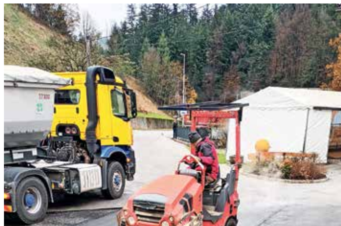
Asfaltiranje v središču Sovodnja FOTO: ARHIV KS
