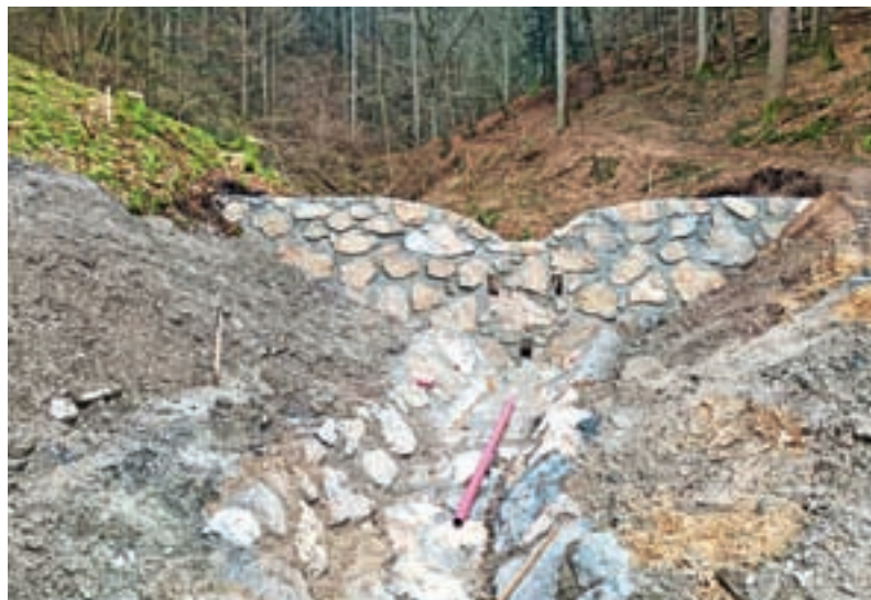
Ureditev pregrad na vodotoku ob cesti v Zakobiljek
