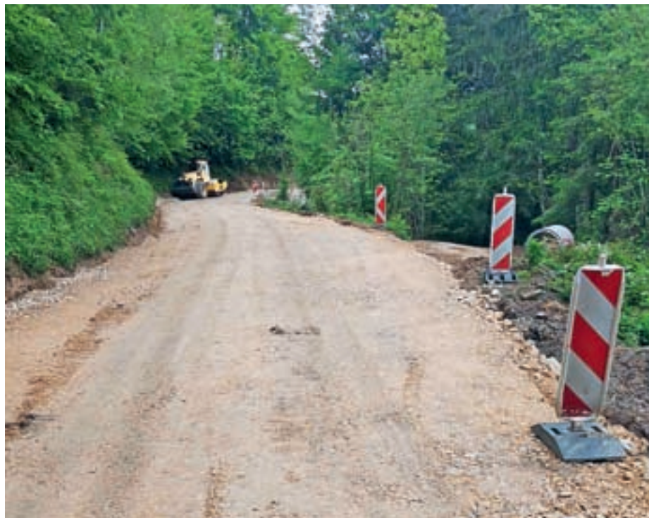
Sanacija cestišča proti Brdom FOTO: ARHIV OBČINE
