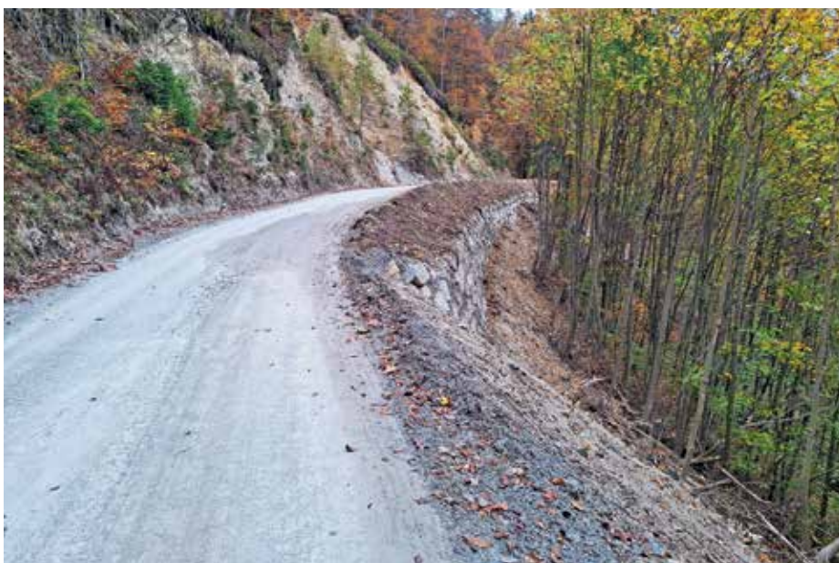
Sanacija plazu na javni poti Suša–Jelovica FOTO: ARHIV OBČINE
