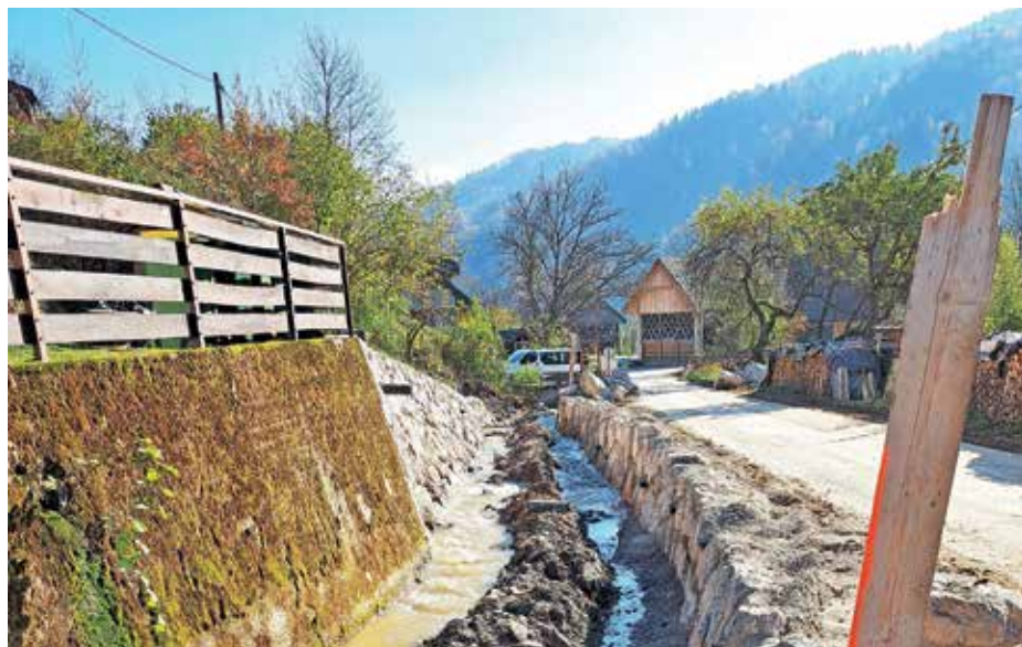
Sanacijska dela na območju Trebije FOTO: ARHIV OBČINE
