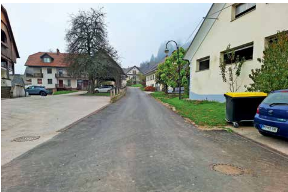
Sanacija dela Poljanske ceste je že končana. FOTO: ARHIV OBČINE
