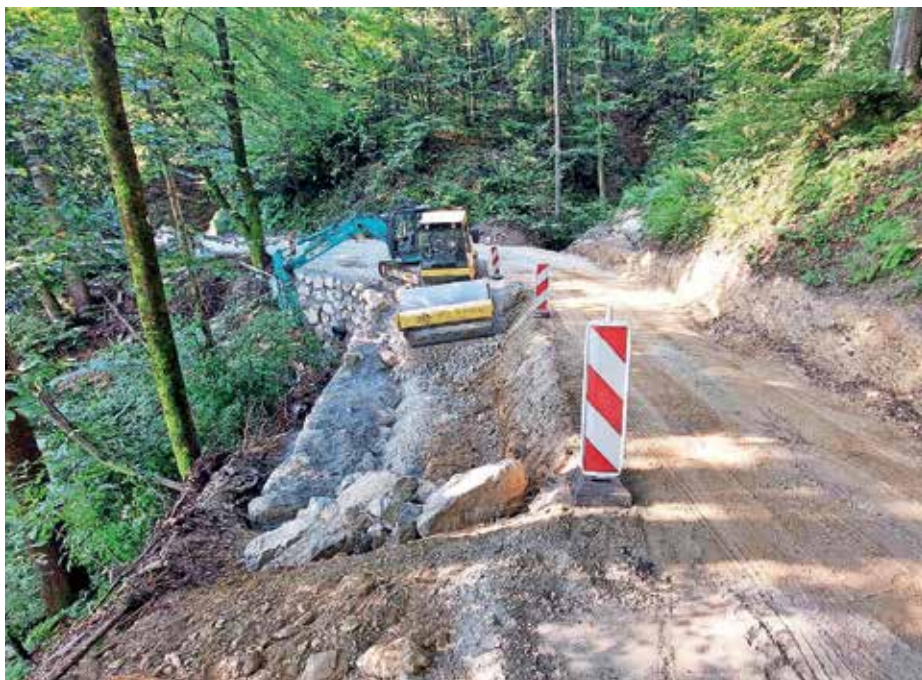
Sanacija usada na cesti v Malenski vrh FOTO: ARHIV OBČINE
