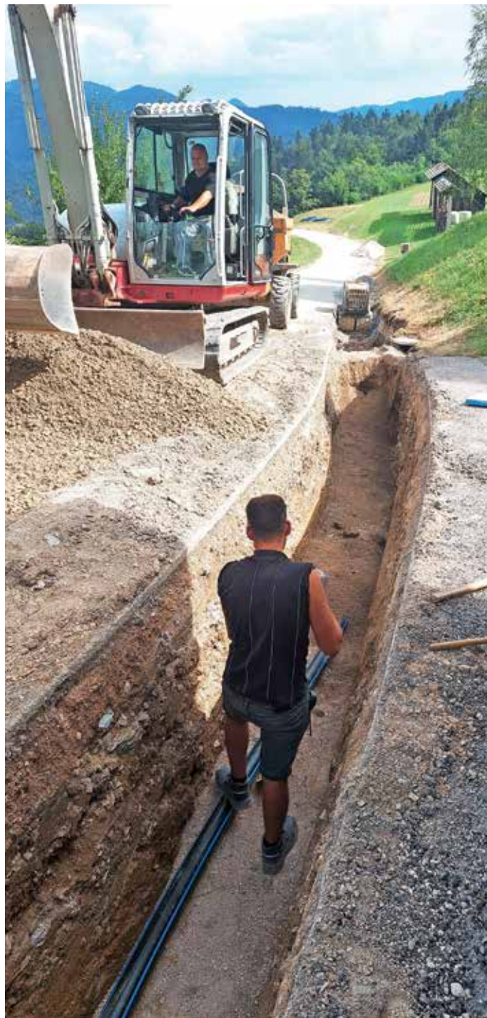
Vkop vodovoda na Dolenjem Brdu FOTO: ARHIV OBČINE
