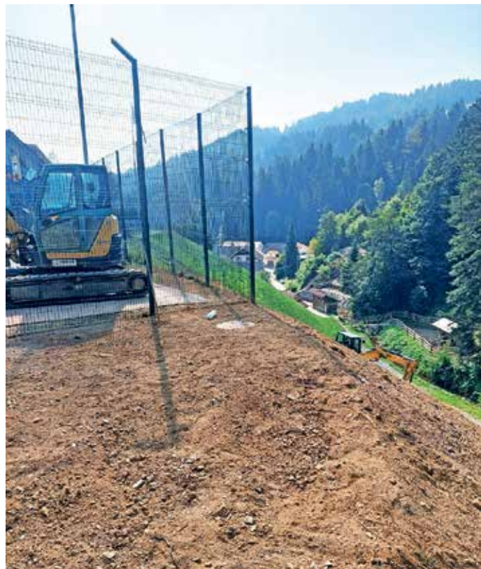
Prenovljeno športno igrišče na Sovodnju FOTO: ARHIV OBČINE
