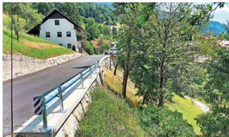
Obnovljen odsek na cesti Leskovica–Novaki FOTO: ARHIV KS
