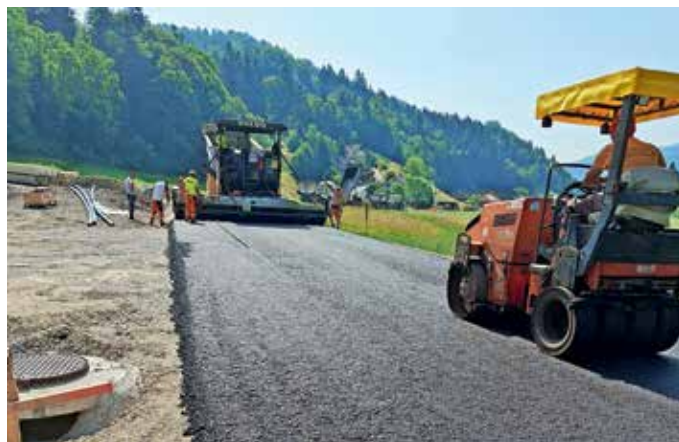
Asfaltiranje ceste v Kopačnici FOTO: ARHIV OBČINE
