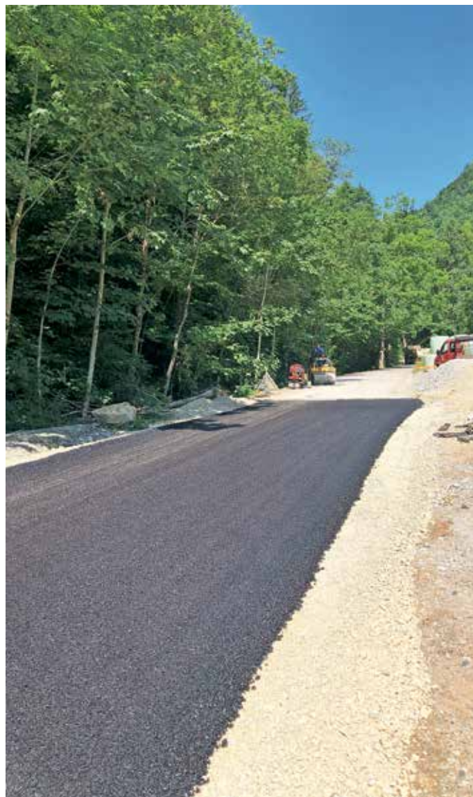
Asfaltiranje ceste na Trebiji FOTO: ARHIV OBČINE
