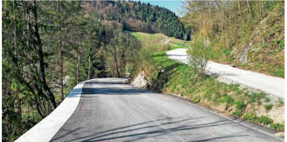
Asfaltiran odsek ceste v Pilovcu v dolžini 150 metrov FOTO: ARHIV KS TREBIJA
