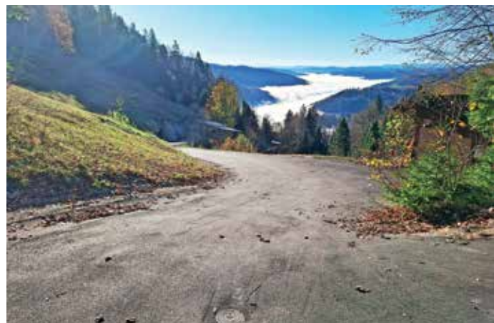
Obnovljen odsek Jelenovše v naselju Stara Oselica
