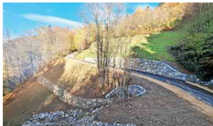
Obnovljeni odsek ceste v Krivem Brdu FOTO: ANTON JEREB
