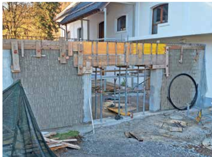
Po zaključku del v notranjosti objekta zdaj poteka še obnova dvorišča. FOTO: JURE FERLAN
