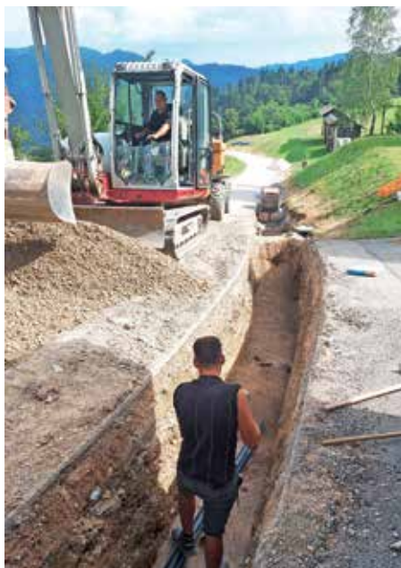
Gradnja vodovoda na Dolenjem Brdu
