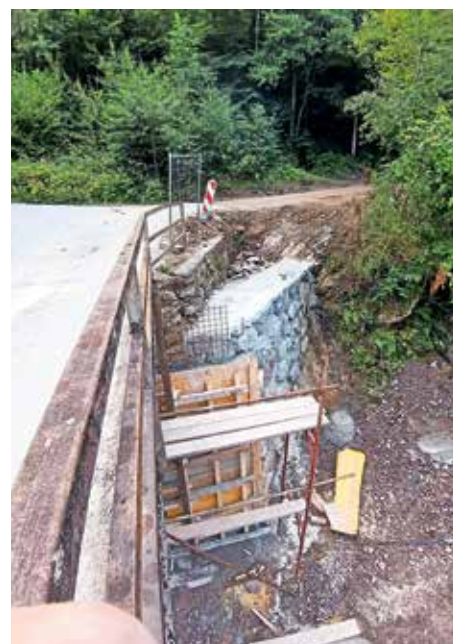
Obnova mostu v Podgori je že končana, v novembru bodo namestili še novo ograjo.
