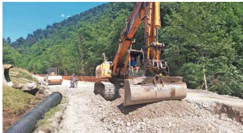
Obnova ceste v dolini Kopačnice bo končana prihodnje leto.
