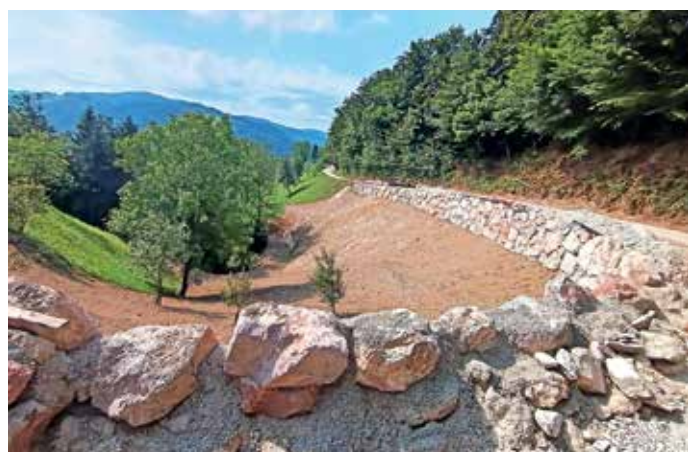
Končuje se obnova lokalne ceste Poljane–Smoldno–Gabrška Gora. FOTO: IGOR KRŽIŠNIK
