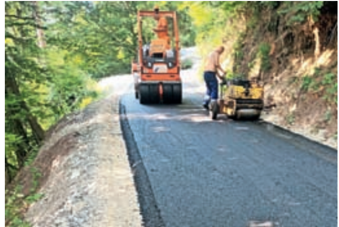
Obnova cest v KS Sovodenj FOTO: ARHIV KS SOVODENJ
