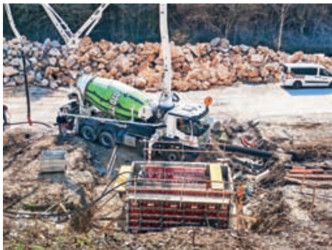
Betoniranje sten pri črpališču Kopačnica FOTO: ARHIV OBČINE
