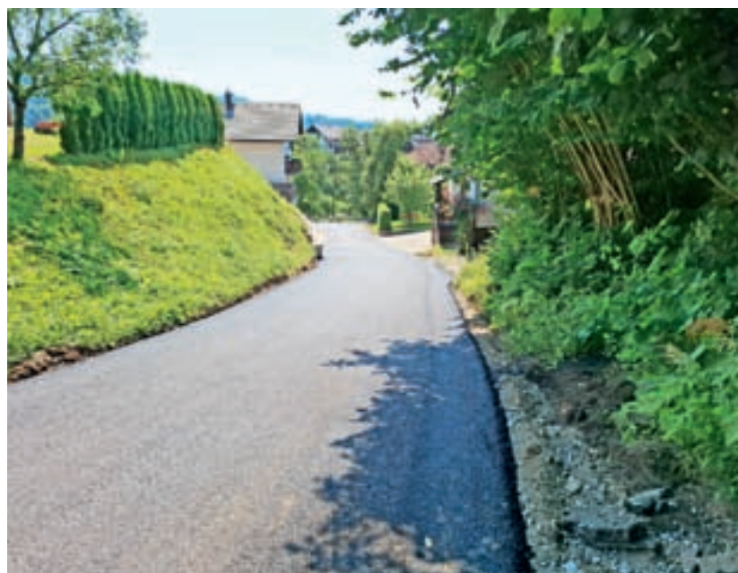
Obnovljeni odsek na cesti Hotavljje–Srednje Brdo
