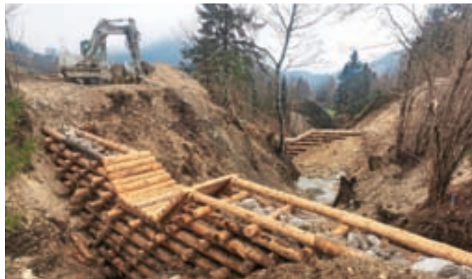
Gradnja pregrad pod mostom na Lazah FOTO: LIDIJA RAZLOŽNIK ČEFERIN
