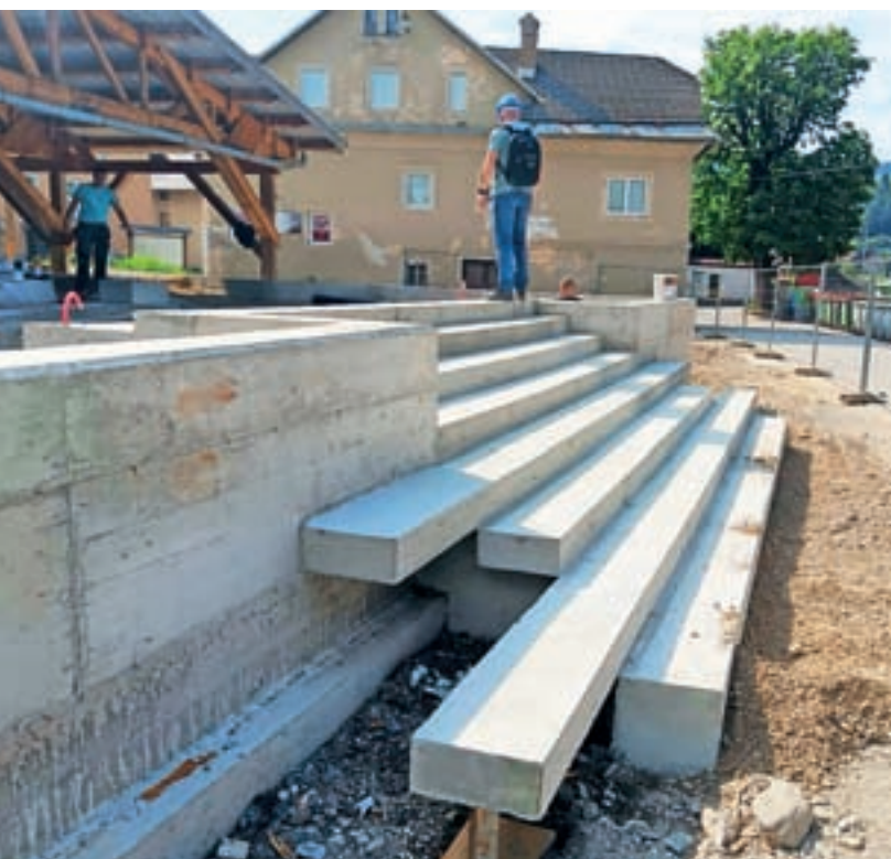
Spodnje vhodno stopnišče je že zgrajeno. FOTO: ARHIV OBČINE
