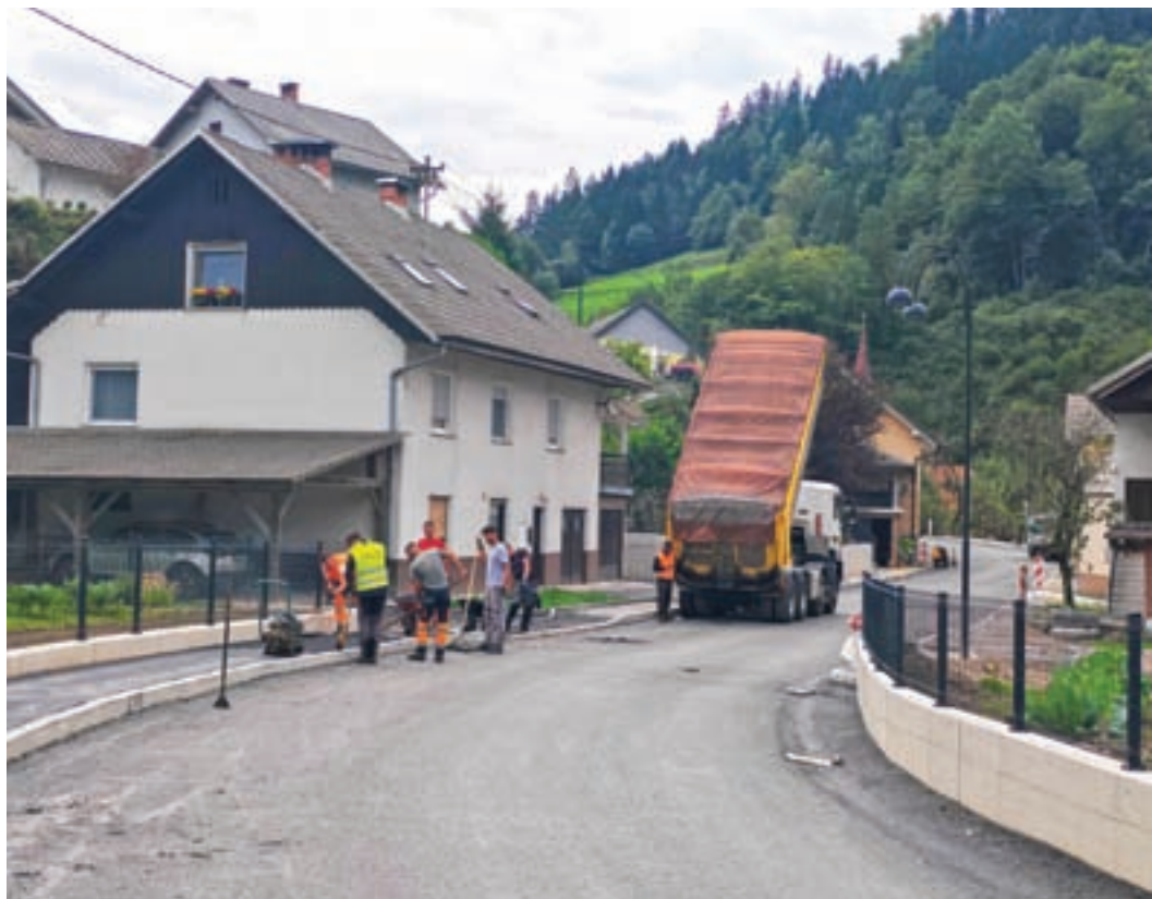
Obnova ceste v dolini Kopačnice FOTO: ARHIV OBČINE
