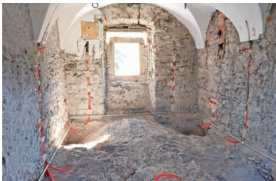
Po odstranitvi dotrajanih ometov so se pokazale močne kamnite stene, zidane z apneno malto. FOTO: JURE FERLAN
