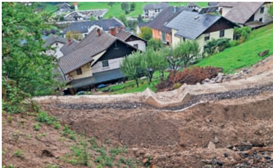
V juniju so začeli dela v okviru enega največjih protipoplavnih projektov v občini.
