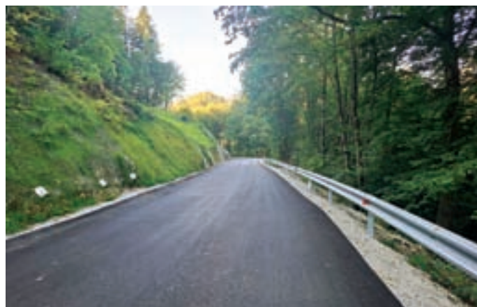
Obnovljeni odsek na lokalni cesti Kopačnica–Leskovača
