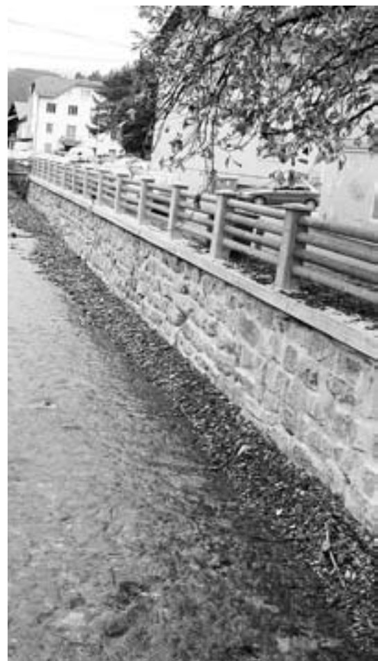
Sanirani oporni zid Ločivnice v Poljanah
