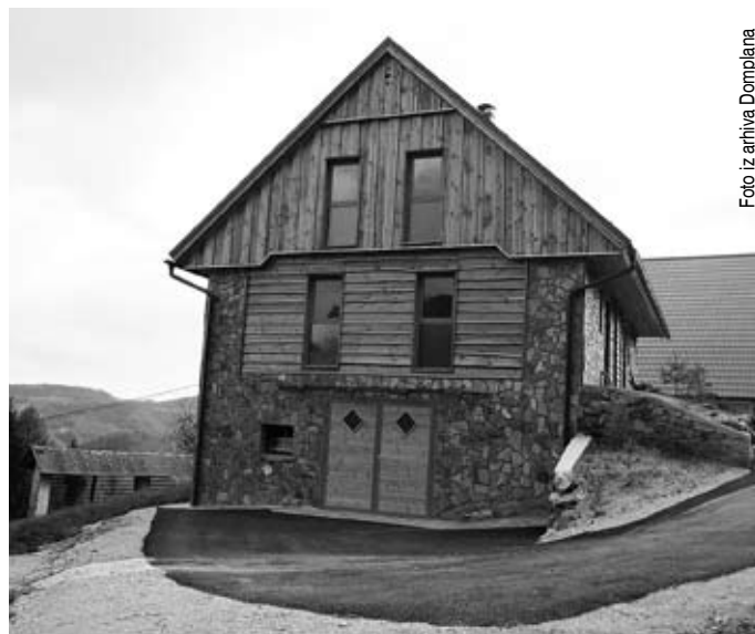
Leskovica: ohranjena razmerja in materiali porušenega gospodarskega poslopja
