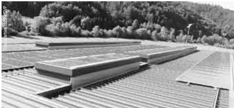
Na streho telovadnice so postavili fotovoltaične module.
