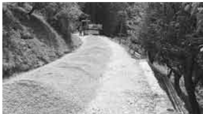
Nasipavanje zgornjega ustroja ceste na 100 m odseku lokalne ceste Sovodenj-Stara Oselica
