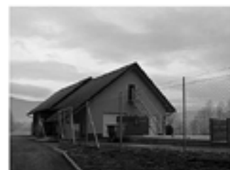
Prenovljena upravna stavba ČN Gorenja vas
