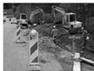
Gradnja primarne kanalizacije na Hotavljah
