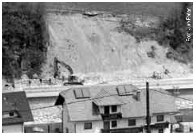
Sanacija plazu na obvoznici pri Vrčajnu
