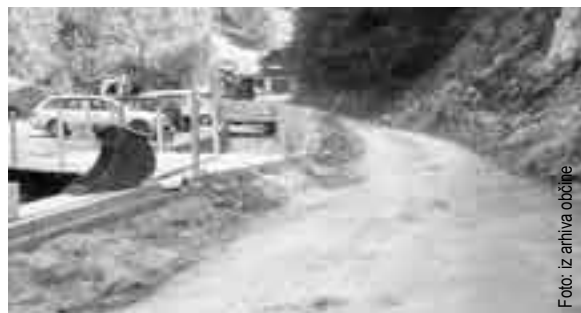
Nov začasen lesen most za obvoz mimo plazu nasproti Mizarstva Peternej-Kržišnik in nadvišani oporni zidovi za potrebe sanacije struge in ceste v istem delu
