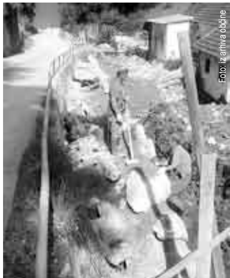
Izgradnja novega opornega zidu na delu mimo stare Kovačije proti ribogojnici Šifrar
