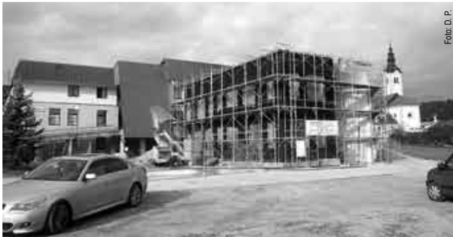
Zadnja dela na prizidku naj bi končali konec letošnjega leta.
