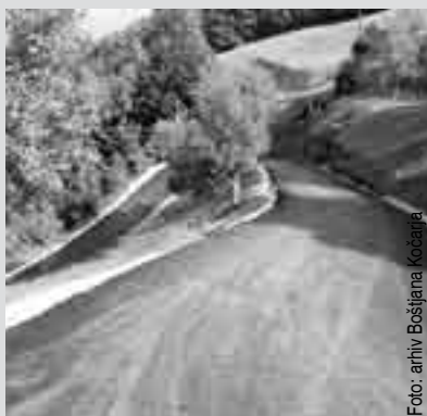
Asfaltiranje strme in serpentinaste poti do Planinčarja v Bukovem Vrh je bilo večinoma ročno delo.
